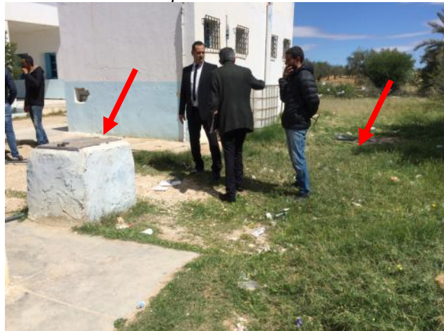
Ecole : pompes et puits perdu
