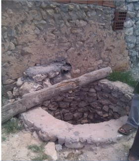
Puit perdu juste à côté du ménage à la zone Garet Annam
