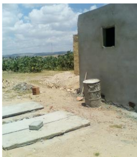
Puit perdu en cours de construction à Garet Annam
