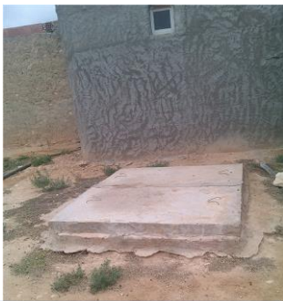
Puit perdu rectangulaire à proximité du ménage à An-Nwayel
