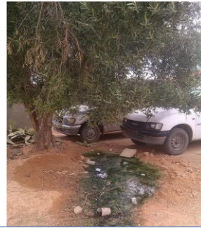
Rejet des eaux grises dans le cours du ménage à An-Nwayel
